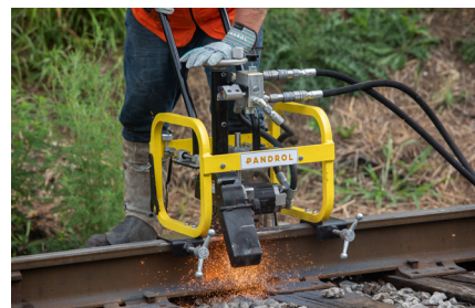
Meulage à l'aide d'une meuleuse hydraulique.
